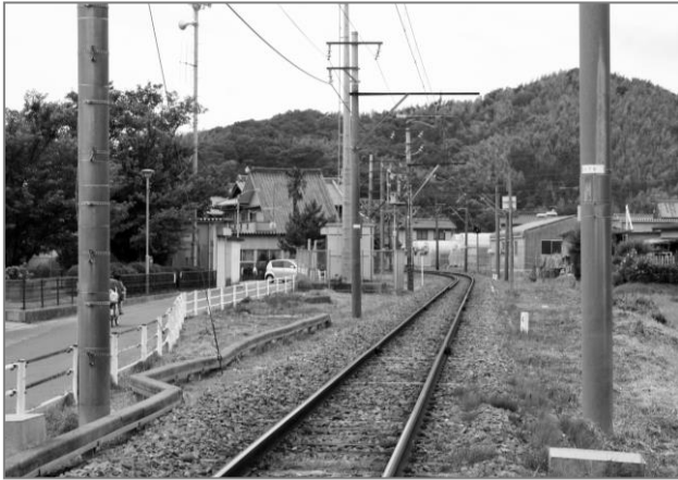
深溝断層により(三河地震…S13.1.13) 三河鹿島～拾石間で線路盛土が崩壊…という記録あり。 場所…三河鹿島～旧拾石間
