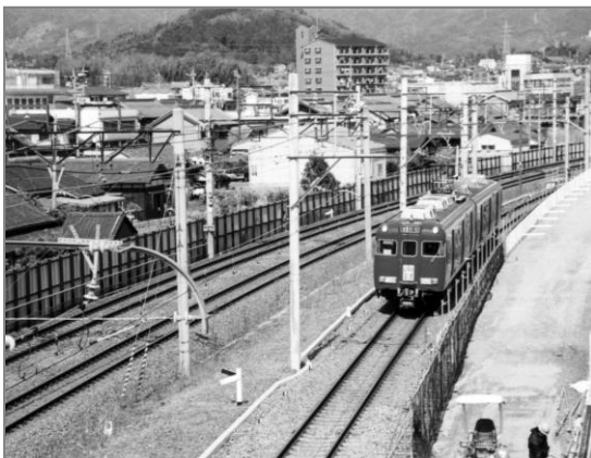
平成 12 年 11 月 11 日 塩見橋～蒲郡競艇場間高架化。(工事のため、JR 下り線を使用)
