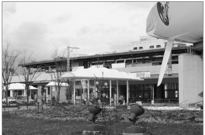
現・名鉄蒲郡駅…平成 22 年 12 月 15 日 (平成 12 年 11 月 11 日新駅舎完成)
