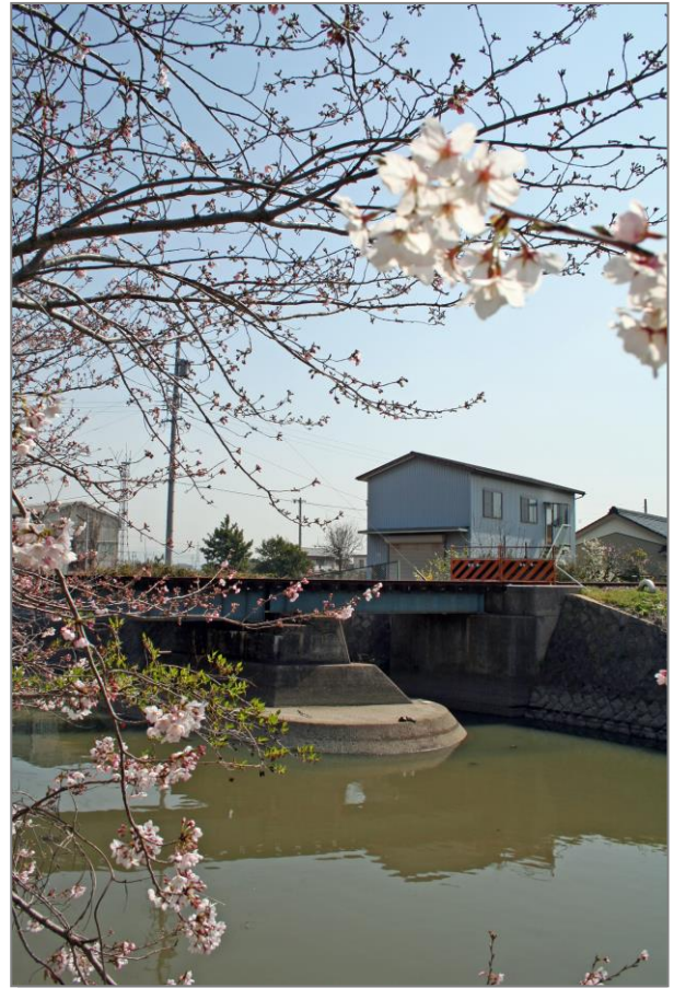
一色排水路…平成18年4月4日
