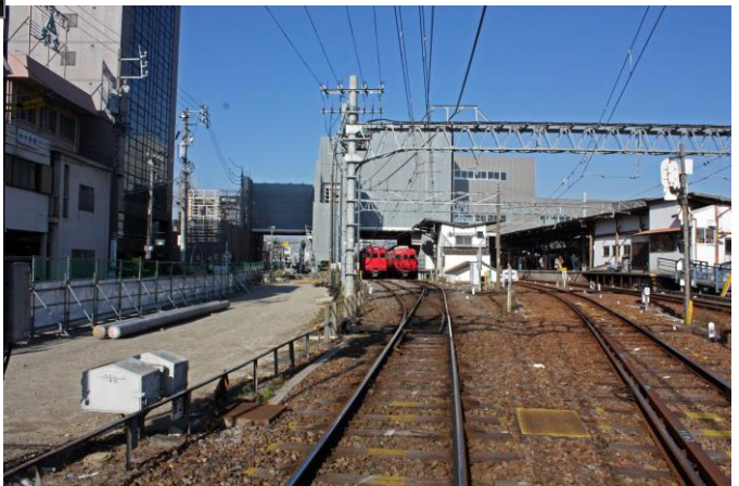
1 番線の海側に仮線用地確保…平成 25 年 12 月 1 日
