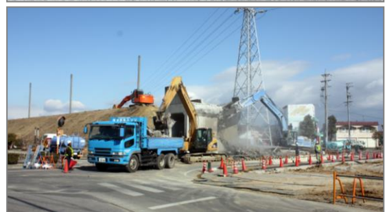
平坂跨道橋…平成 23 年 1 月 20 日解体
