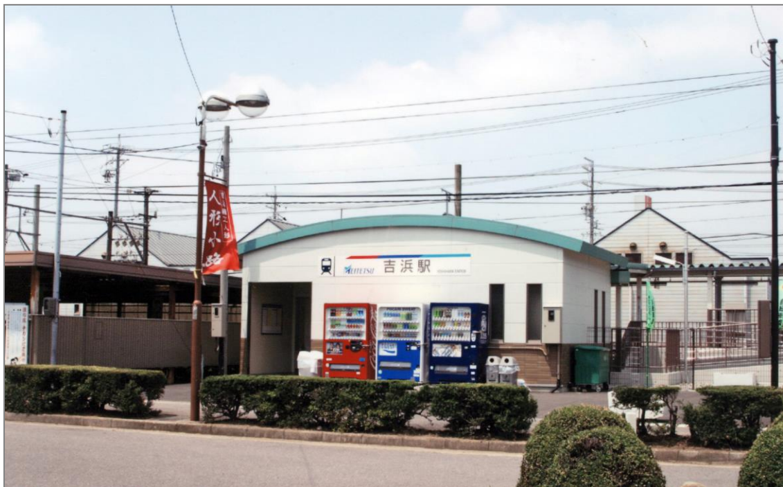
平成 17 年 9 月 14 日…駅管理システム導入のため再改築
