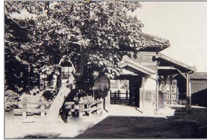
駅舎撤去…昭和 45 年
