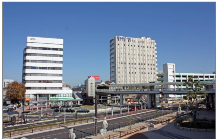
平成 20 年 12 月 1 日、駅南口のペデストリアンデッキ 「みなくる刈谷ウイングデッキ」が完成、南北自由通路 と接続し使用開始。 平成 21 年 11 月 26 日
