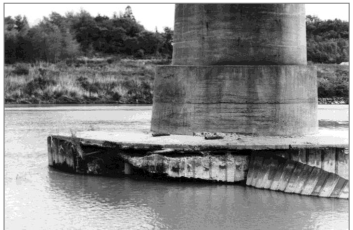
下…挙母線の矢作川橋梁
