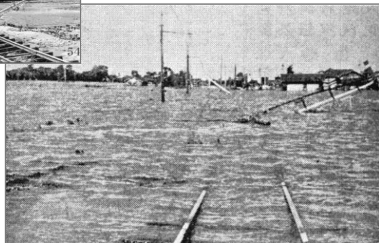
松木島上り場内信号機(腕木式)倒壊
