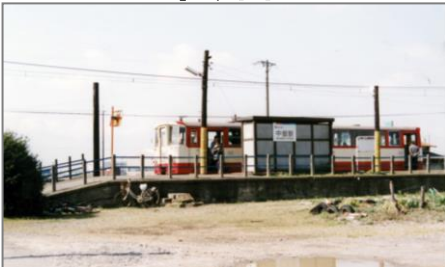
ホーム&上屋撤去…平成 17 年 7 月
