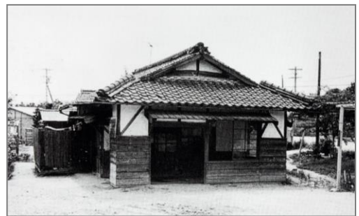
駅舎撤去…昭和41年
