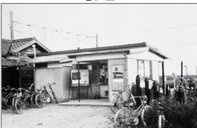
駅舎撤去…昭和 44・45 年頃
