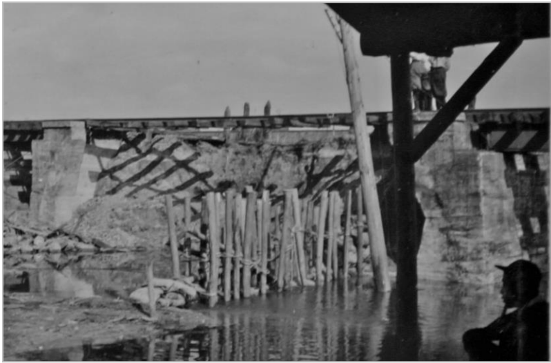
上及び右…玉津浦～碧南間(第1堀川橋梁)
