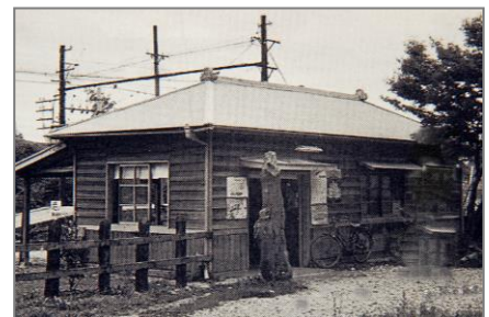
駅舎撤去…昭和42・43年頃
