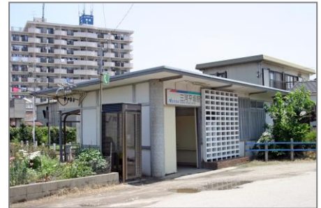
駅舎撤去は廃線後…平成 18 年 6 月
