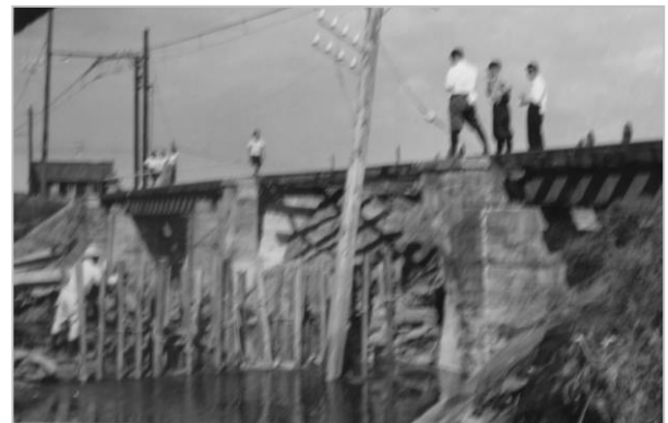
三河一色～西一色間…上2枚→補強された一色排水路の橋脚 左側の写真では右側の橋脚
