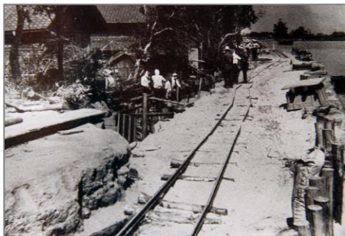
矢作古川右岸・堤防応急復旧工事
