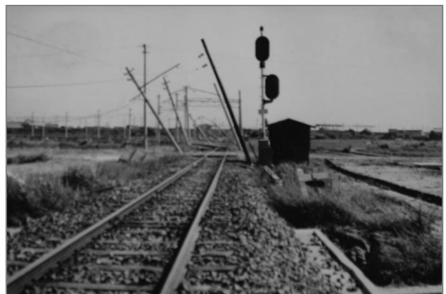
重原～知立間 知立第1場内信号機付近
