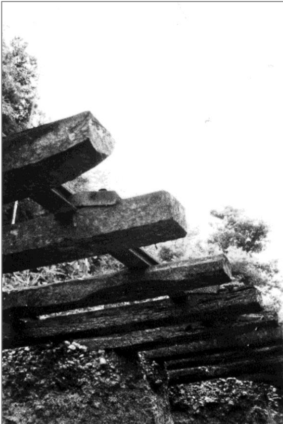
広瀬トンネル～カ石トンネル間
