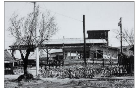
駅舎撤去…昭和 42 年
