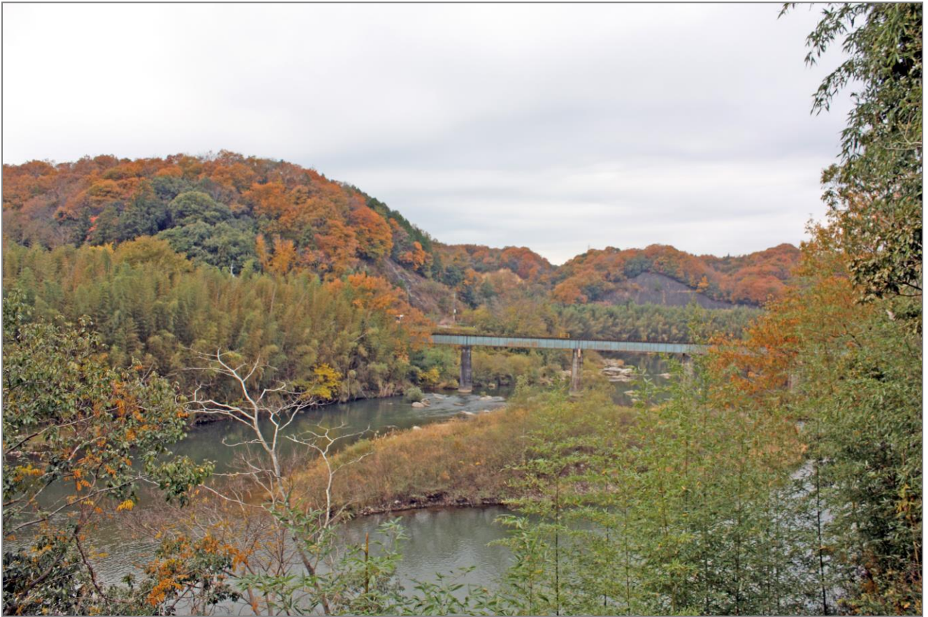
山々の紅葉に包まれた橋梁…平成 21 年 11 月 27 日
