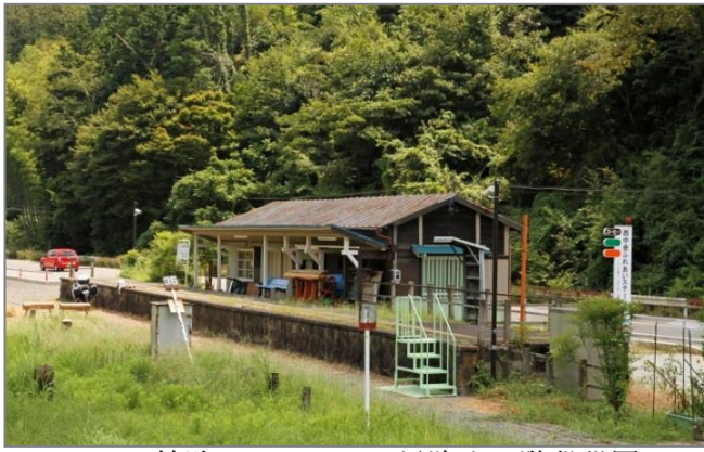
旧・線路とホームへの昇降する階段設置
