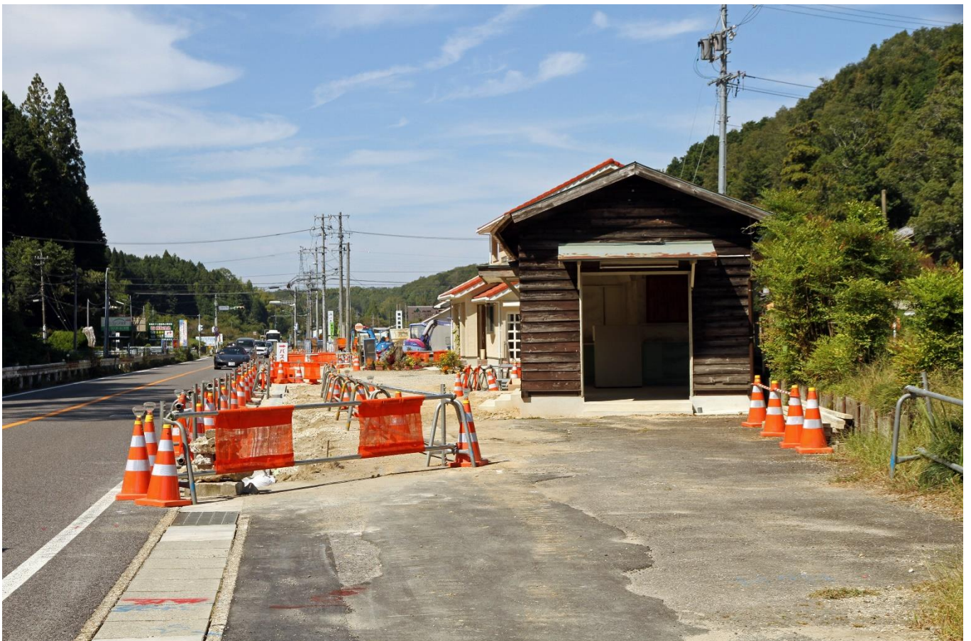
156 号線に歩道新設のため駅舎を北側へ曳家…平成 26 年 9 月 21 日
