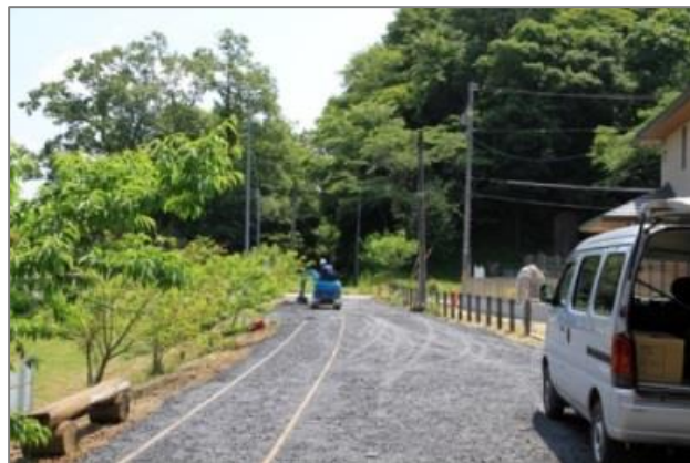
駐車場…更地に整備後…細かい砕石を敷く
