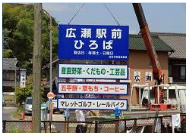
駅前ひろばの看板を取付け中…平成 22 年 6 月 2 日
