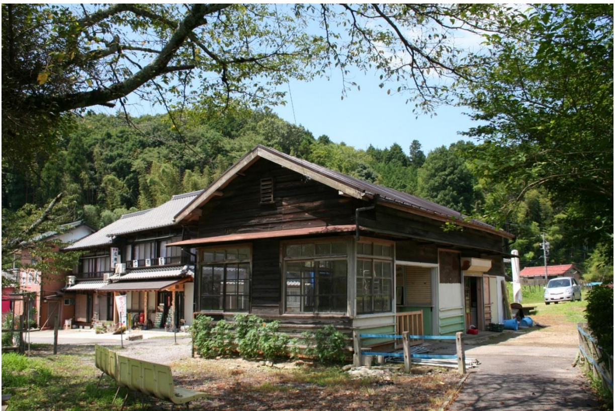
平成 18 年に入ると駅舎(待合室や駅長室内の内装や外装)を修繕し出す。この写真を見ても待合室の通路柵(旧改集札口)が真新しいのが解る。…平成 18 年 7 月 27 日
