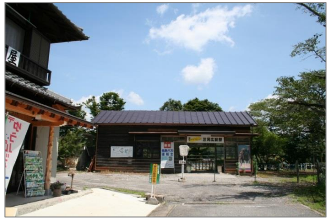
屋根の塗装も完成。入口に「夢街道でんしゃみち」の看板を掲げる。…平成 18 年 7 月 4 日
