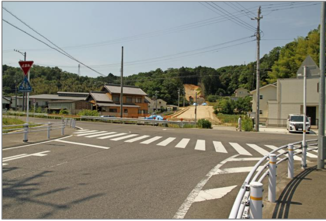
三河広瀬 1 号踏切から南に道路新設工事…153 号線へ 通ずるバイパス道路を建設か…平成 29 年 6 月 10 日
