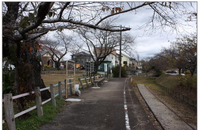
ホームの上屋が撤去されていた…令和5年12月2日
