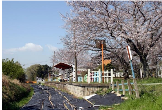
黒ビニール(雑草防止)を敷く…平成 19 年 4 月 4 日
