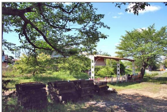
枕木搬入…平成 19 年 5 月 20 日
