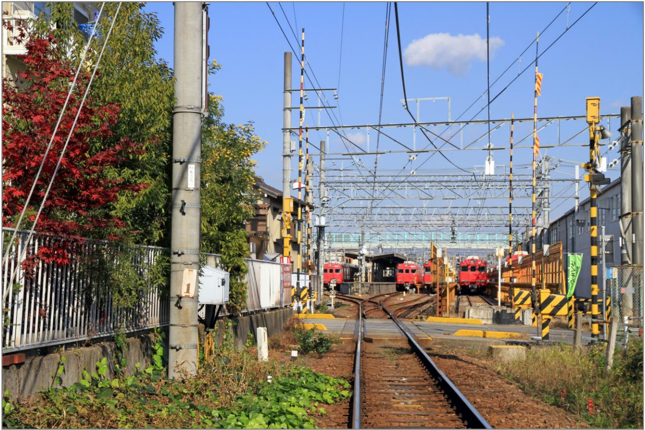
構内風景…平成 22 年 11 月 26 日
