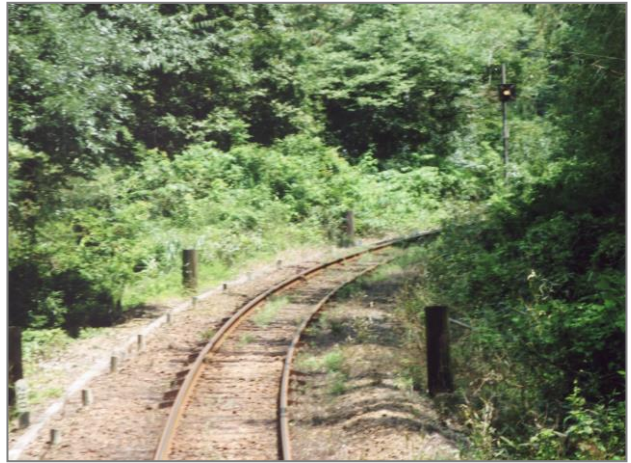
下り列車…三河広瀬1～2号踏切間
