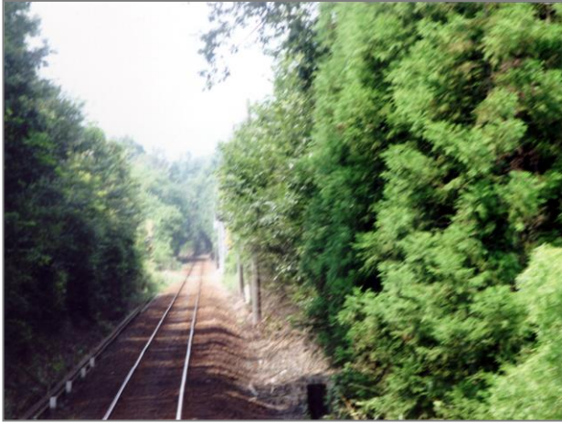
御船川から御船方へ 50 ㌔を過ぎた 20%上り勾配
